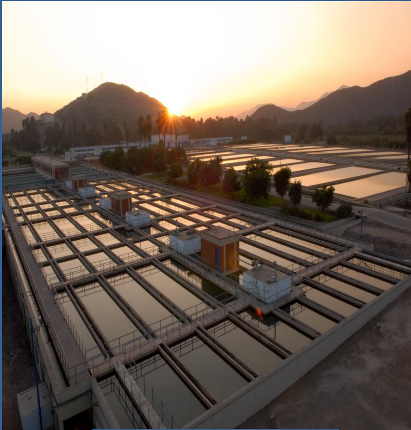
Planta de Tratamiento de Agua N° 02 - Atarjea
