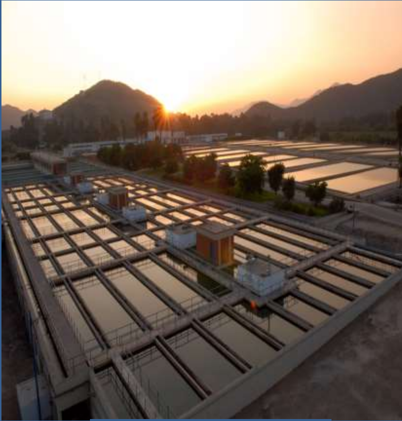
Planta de Tratamiento de Agua N° 02 - Atarjea
